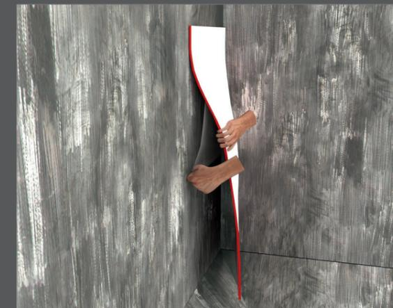
4. Die Schutzfolie mit der linken Hand abziehen und mit der rechten Hand andrücken
